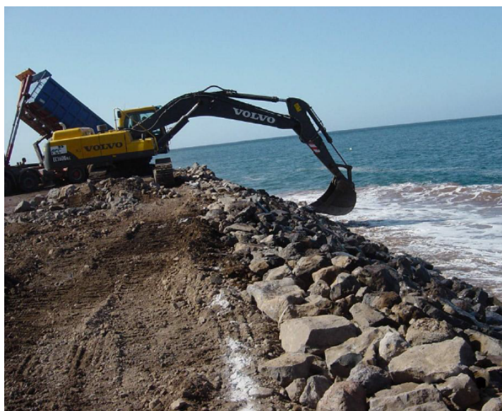
Figura B.4: Perfilado de manto de escollera con retroexcavador
