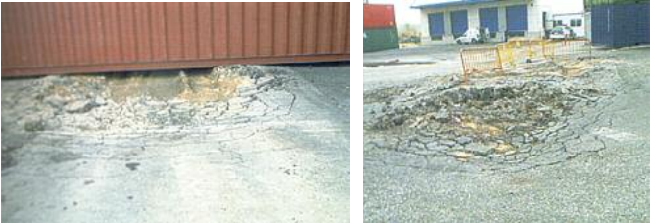
FIGURA 33. Izquierda: Ejemplo de daños en un pavimento que condiciona su utilización con alguna restricción. Derecha: Daños sobre el pavimento de un puerto que podrían calificarse como ruinosos
