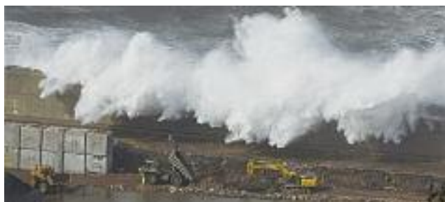
FIGURA 1. Episodio de rebase sobre un dique de abrigo que supone una amenaza para un área de explotación que resulta vulnerable
