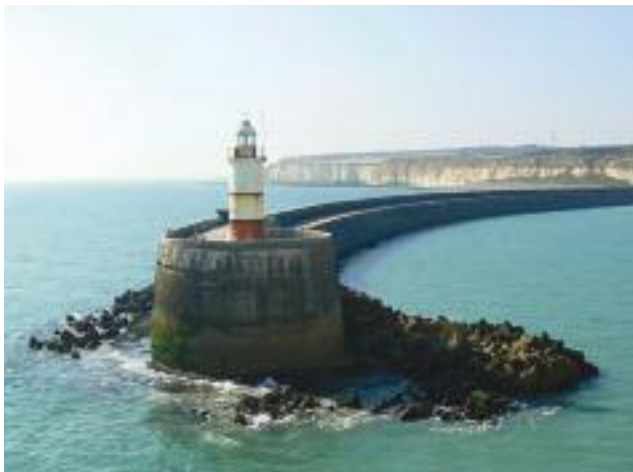
FIGURA 49. Ilustración del modo de fallo “Extracción de piezas” en el morro de un dique
